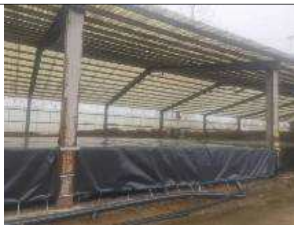
牛粪大棚粪污收集池、固液分离区加盖密闭
