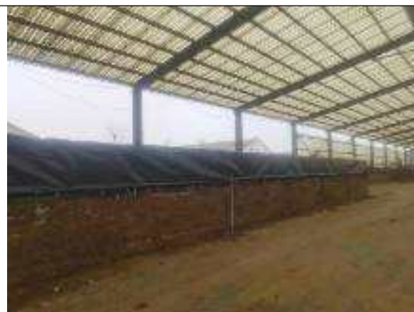
牛粪大棚粪污收集池、固液分离区加盖密闭
